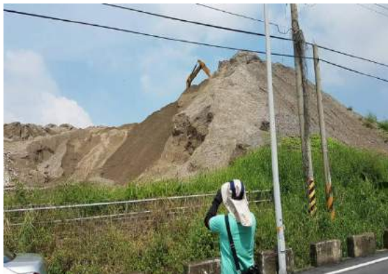
堆置場無防制措施
