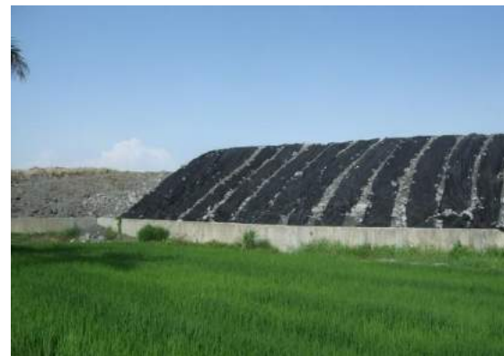
堆置場覆蓋面積不足
