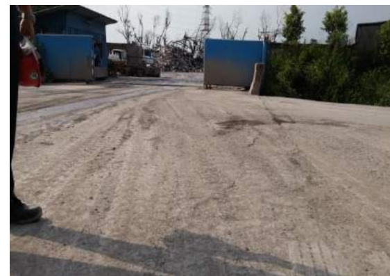
車行路徑路面色差
