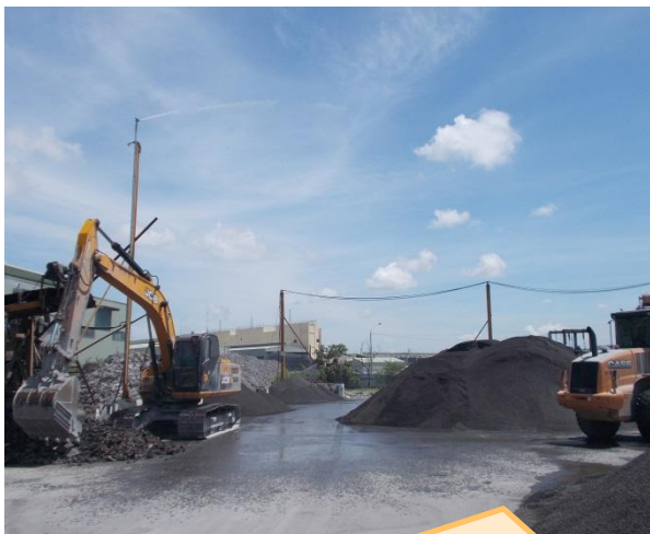
堆置場皆未達覆蓋面積80%
