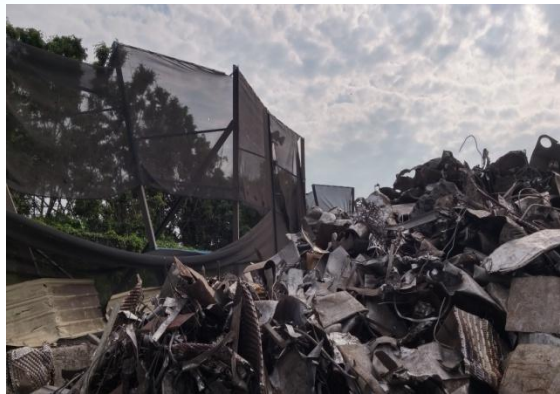
堆置場阻隔牆損壞
