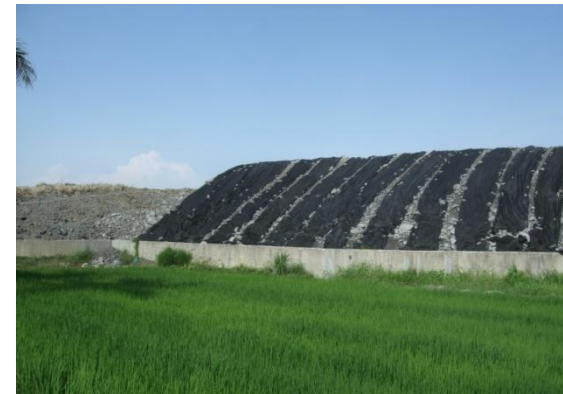
堆置場覆蓋面積不足
