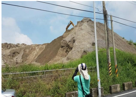
堆置場無防制措施
