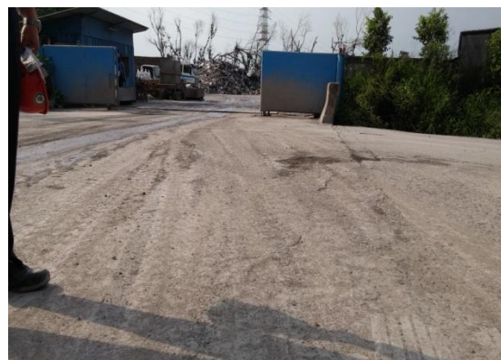
車行路徑路面色差
