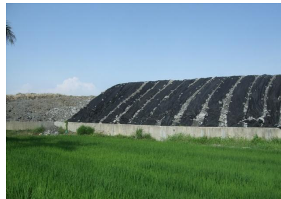
堆置場覆蓋面積不足
